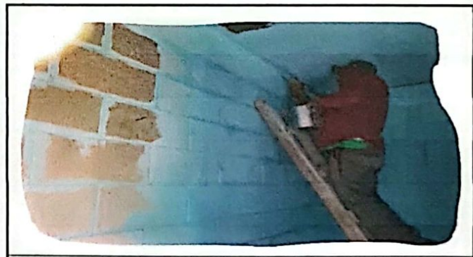
Foto 6: Pinturas exteriores e interiores
