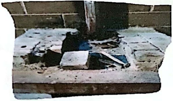
Foto 9: Reparacion de plancha
