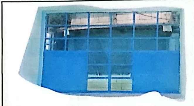
Foto 1: Reparación de ventana
