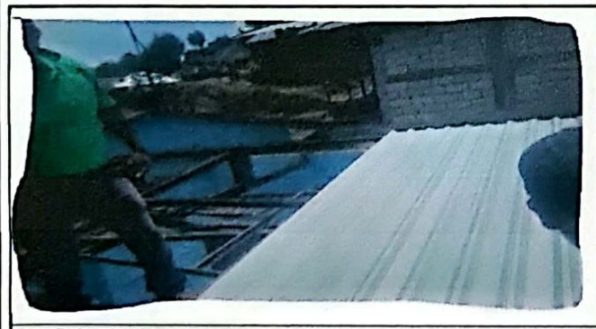
Foto 5: Sustitucion de techo
