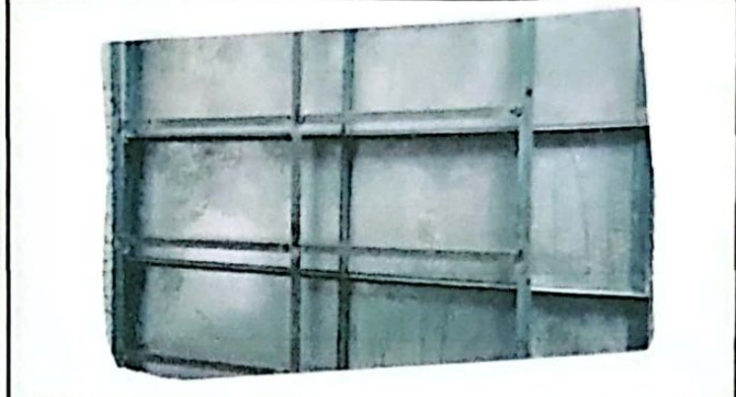
Foto 2: Sustitucion de ventana
