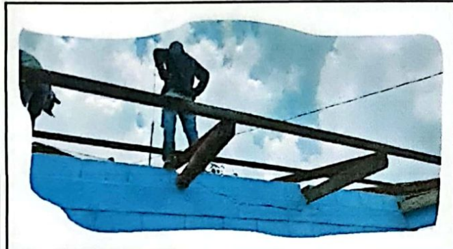
Foto 3: Sustitucion de techo
