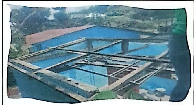
Foto 4: Sustitucion de techo
